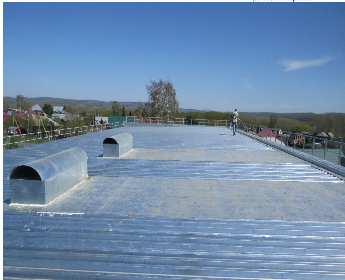
Ремонт кровли здания УСЗН
