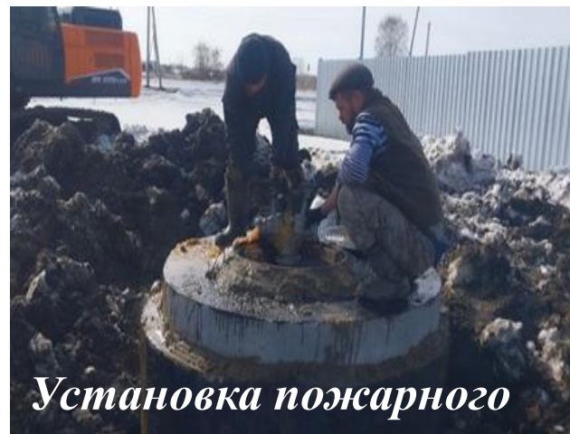
Установка пожарного гидранта в с Банново
