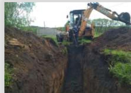
Заменено 3,1 км ветхих водопроводных сетей; проложено 0,9 км нового водопровода; заменена теплоизоляция трубопровода надземной тепловой сети 1,3 км.
